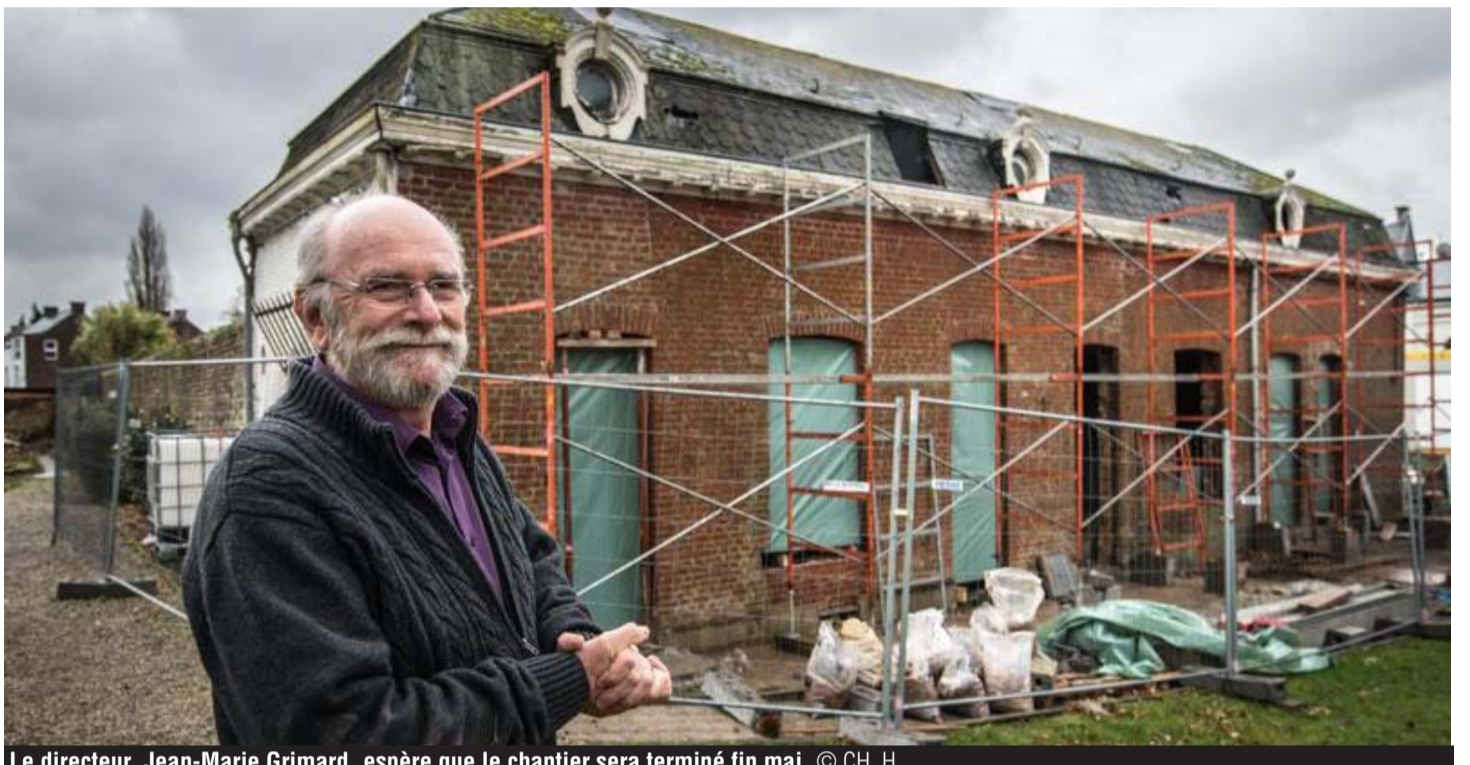
Le directeur, Jean-Marie Grimard, espère que le chantier sera terminé fin mai. © CH. H.
